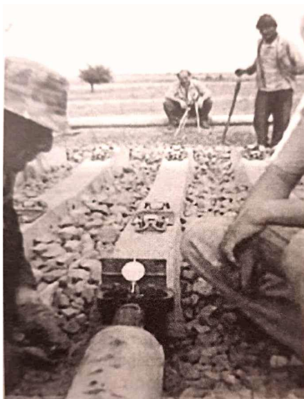
Рисунок 4.2 – Определение сдвигающих усилий одиночных шпал типа BF70 [135]
